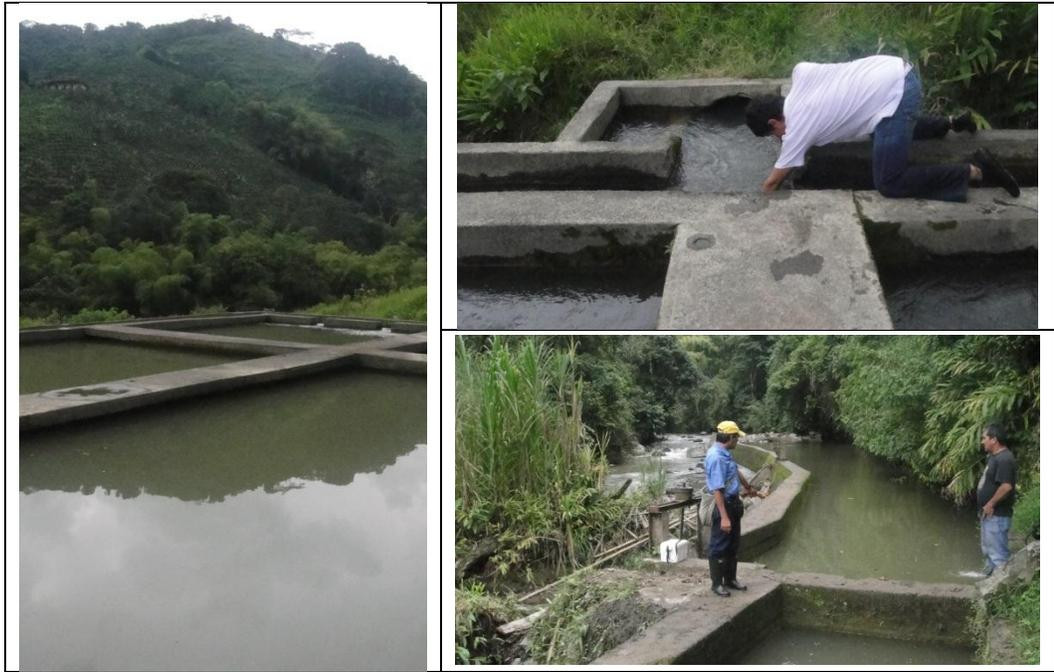
**Figura 10.** Desarenador Campoalegre (lateral izq. y sup. Derecha) y bocatoma Campoalegre (acueducto de Chinchiná y Pensilvania, Caldas).
