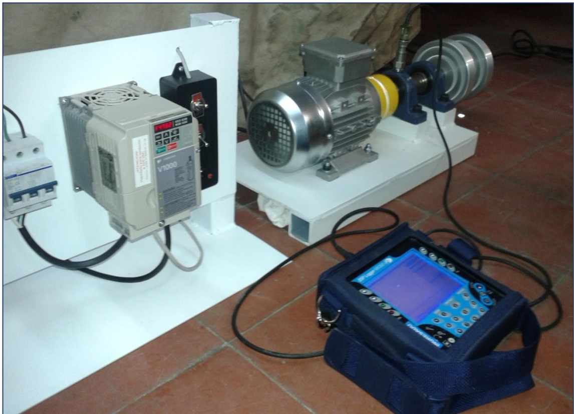
Figura 30. Medición con el medidor de vibraciones DSP logger MX300 .
