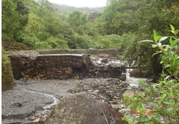
Figura 24. Gaviones arrastrados por la Quebrada Las Palmas
