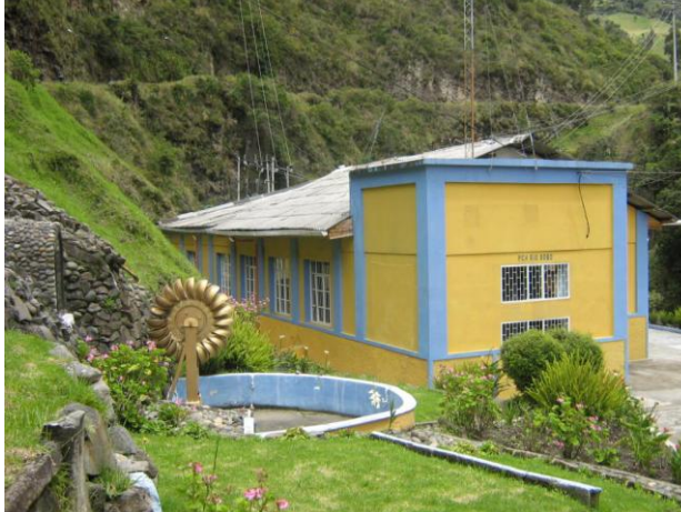
Figura 15. Exterior de la PCH Río Bobo.
