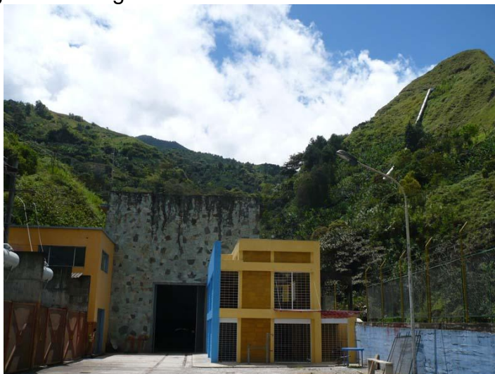
Figura 2. Fotografía Central Hidroeléctrica de Río Mayo.
