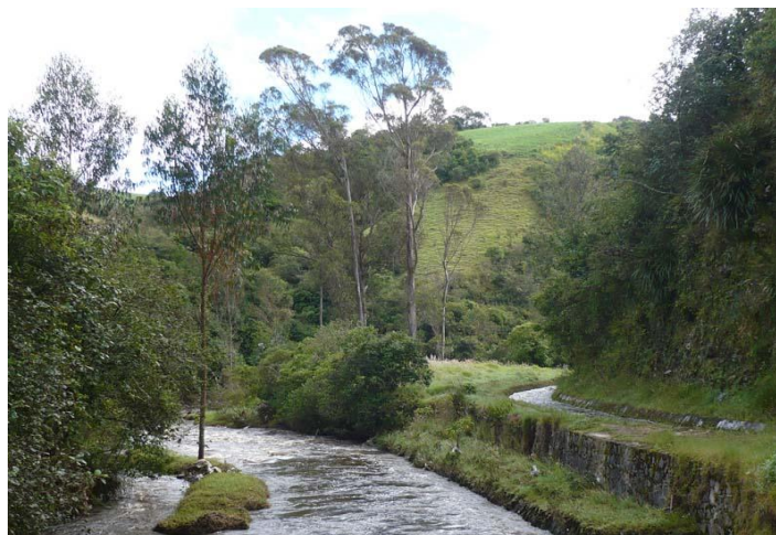
Figura 21. Conducción de agua para generación dentro de un medio natural.
