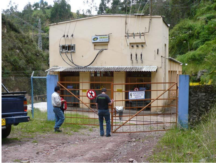
Figura 6. Fotografía Pequeña Central Hidroeléctrica Río Sapuyes.
