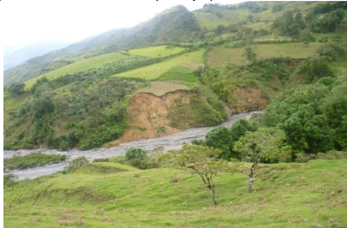
Figura 25. Alteración del paisaje por erosión en taludes.
