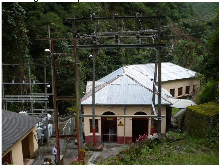
Figura 8. Fotografía Pequeña Central Hidroeléctrica Julio Bravo.
