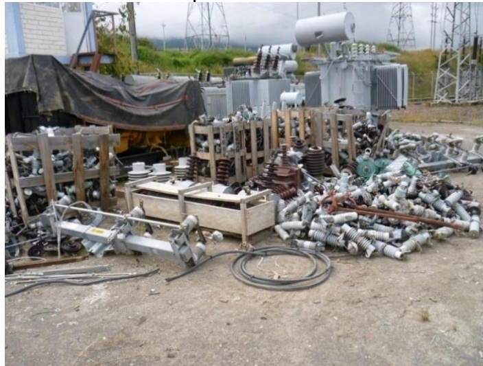
Figura 13. Inadecuada disposición de elementos residuales.
