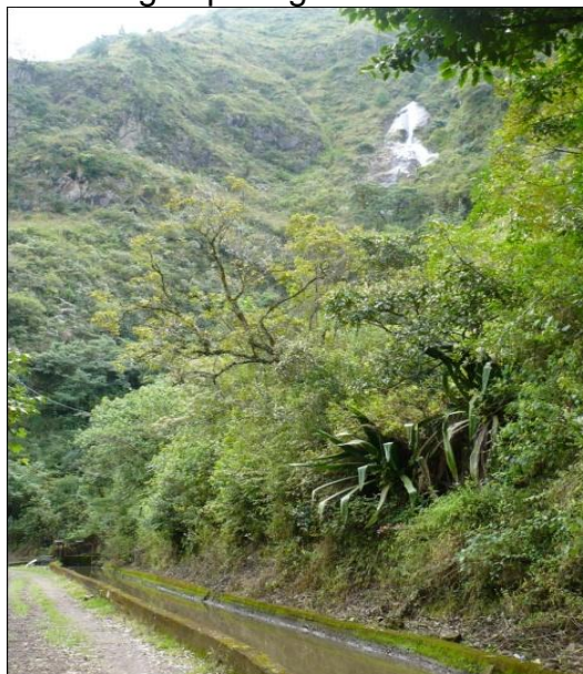
Figura 18. Conducción de agua para generación dentro de un medio natural.
