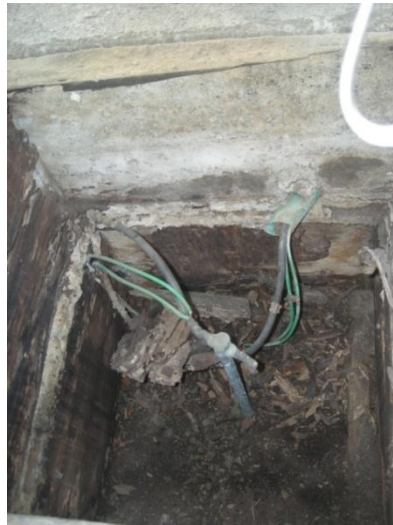
Figura 48. Electrodo de puesta a tierra
