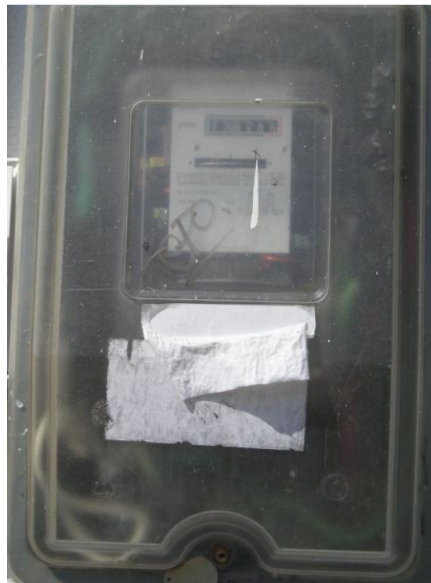
Figura 35. Medidor bifásico trifilar
