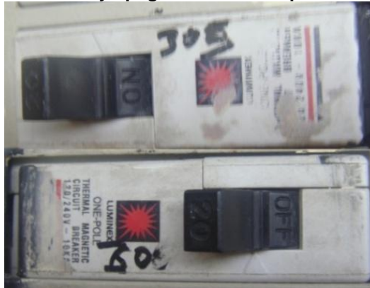
Figura 27. Posiciones de encendido y apagado del interruptor
