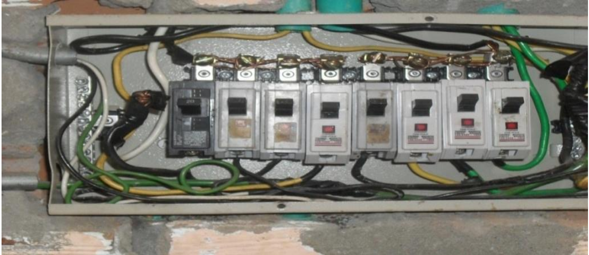
Figura 33. Identificación de circuitos ramales
