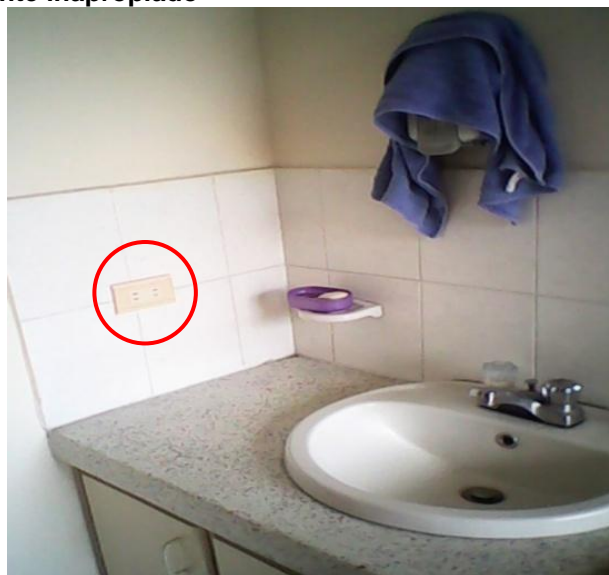
Figura 20. Tomacorriente inapropiado
