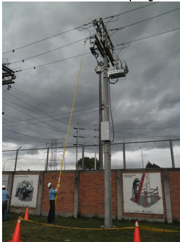
Figura 17. Verificación de ausencia de tensión con pértiga
