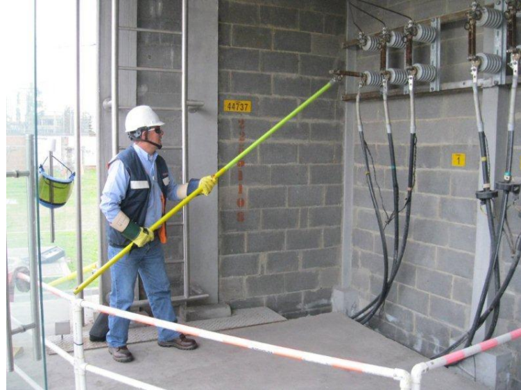
Figura 22. Apertura de un seccionador monopolar con método a distancia
