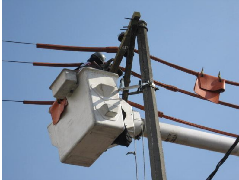
Figura 23. Cambio de aisladores tipo pin en línea energizada
