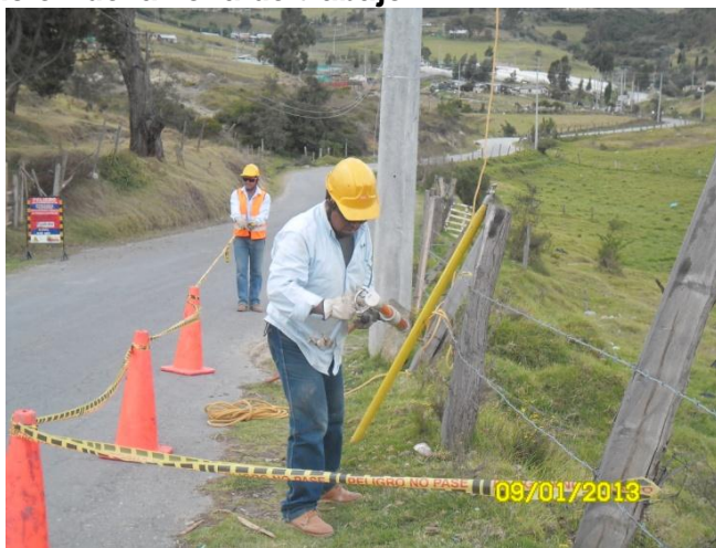
Figura 14. Señalización de la zona de trabajo
