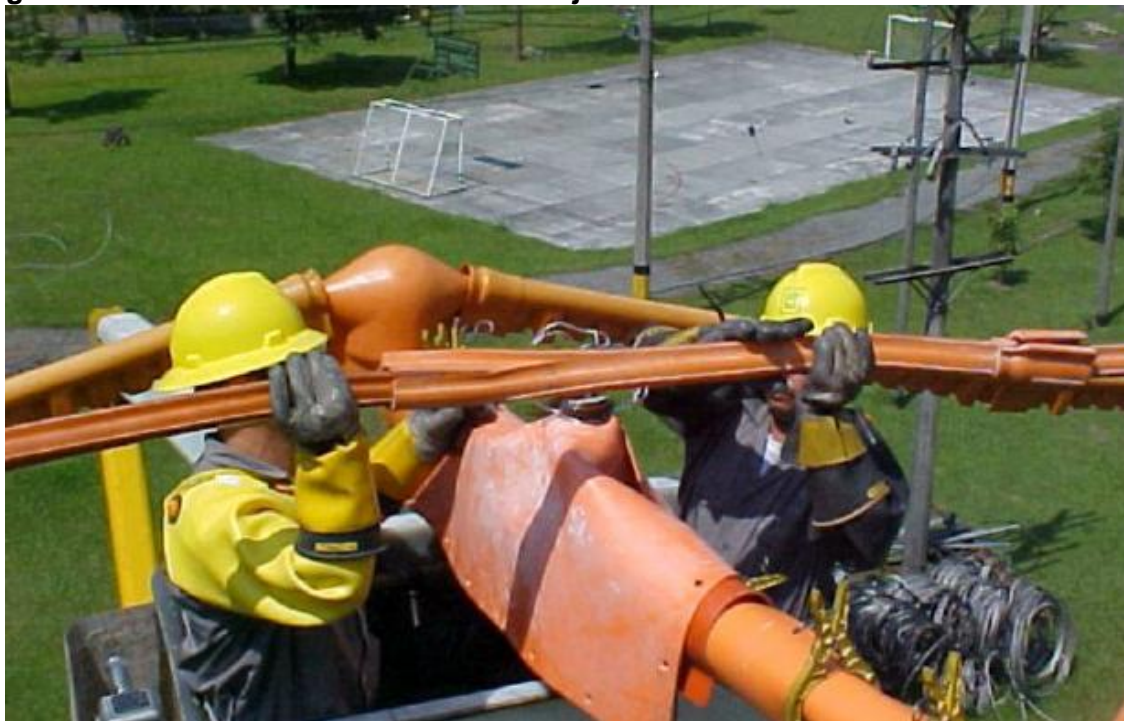
Figura 27. Cubrimiento de la zona de trabajo en línea viva
