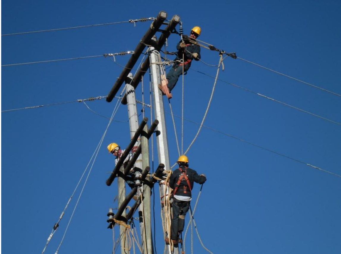
Figura 10. Cambio de una estructura en H en línea desenergizada
