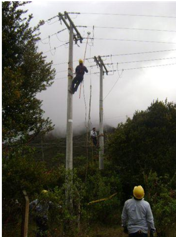
Figura 18. Fijación del sistema de puesta a tierra temporal en la red de media tensión
