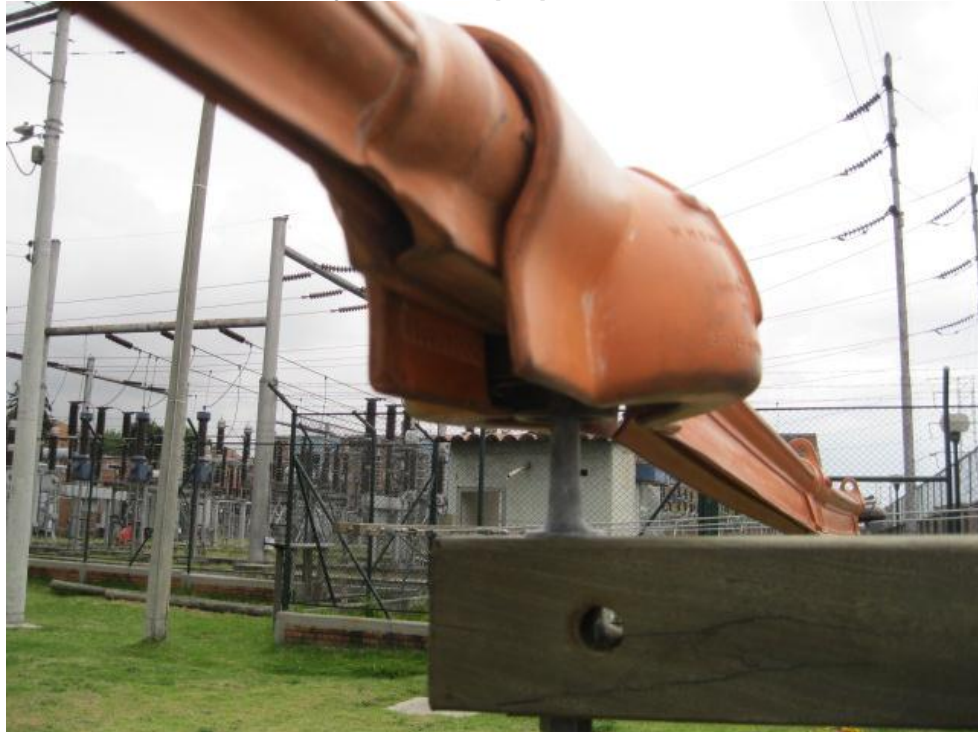
Figura 25. Cubridores de línea y aislador tipo pin
