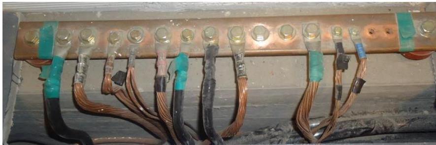
**Figura 8. Sistema de puesta a tierra para telecomunicaciones.**
