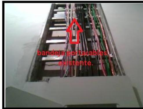
Figura 28. Bandeja porta cables existentes.
