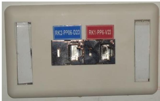
**Figura 48. Marcación de los puntos voz y datos.**
