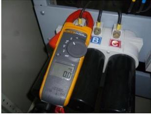
Se probaron los condensadores en la prueba se determino que los 3 tienen de a un condensador malo, se recomienda cambio .
