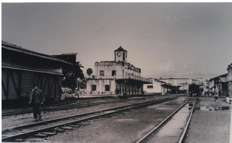
Estación del Ferrocarril - Archivo fotográfico de la UTP
