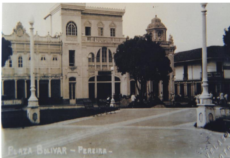
Plaza de Bolívar Cra. 8ª. con calle 20 - Archivo fotográfico de la UTP
