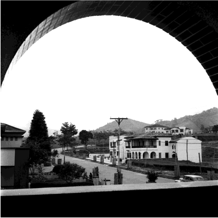
Avenida Circunvalar. Foto: Donato Garcia.
