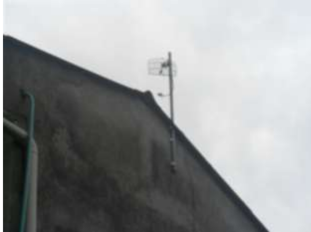
Figura 39 Antena de WI-FI.
