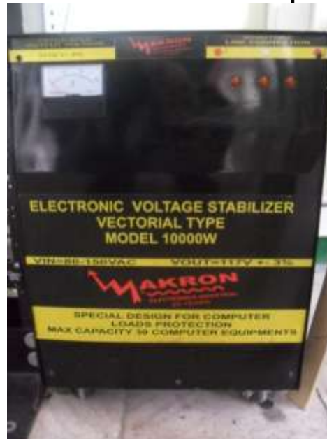
Figura 28 Estabilizador de la sala de sistemas del primer primero piso
