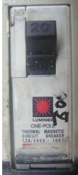
Figura 31: Especificaciones de corriente y tensión en interruptores
