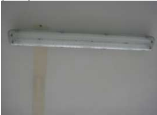
Figura 46. Aula de clase primer piso
