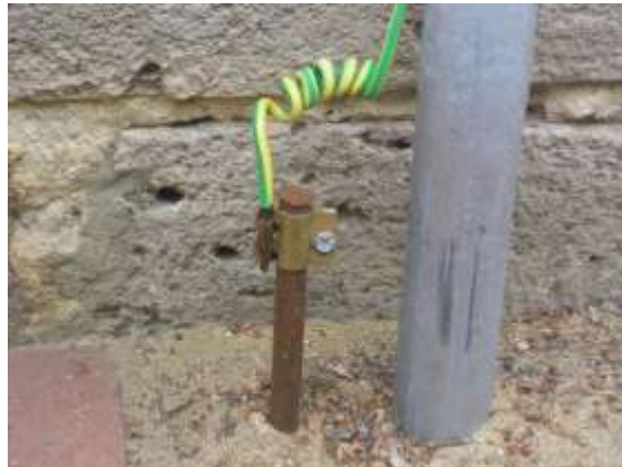
Figura 7. Electrodo de puesta a tierra
