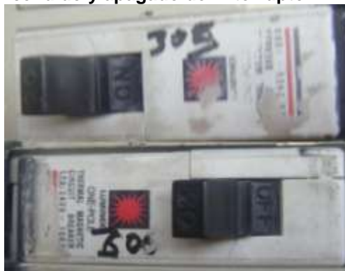
Figura 32. Posiciones de encendido y apagado del interruptor
