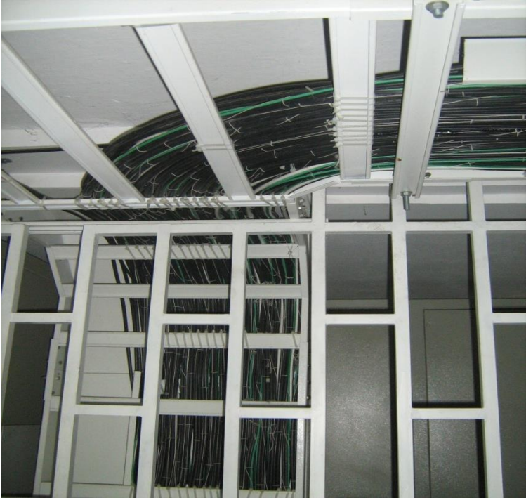
Figura A 3. Utilización bandejas portacables.
