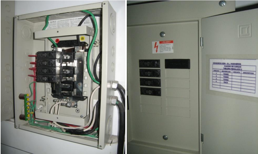
Figura A 28. Disposición de conductores tablero regulado #5 Multimedia I E-113
