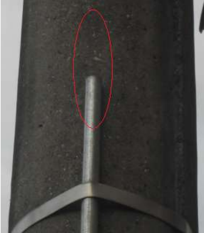
Figura 12. Puesta a tierra del transformador
