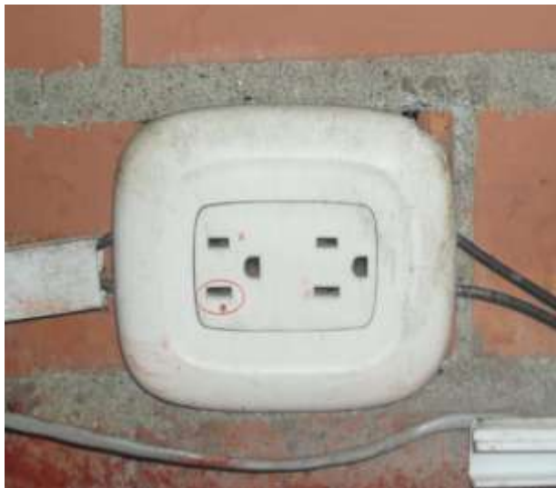
Figura 25.Posición incorrecta del neutro
