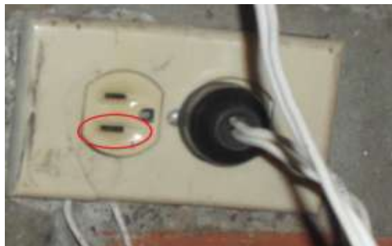
Figura 31. Posición incorrecta del neutro
