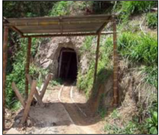
Túnel de acceso a la mina.
