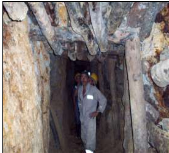
Estructura de entibación de la mina.
