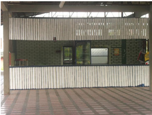
Foto No.43: Cafetería Fuente: Propia.
