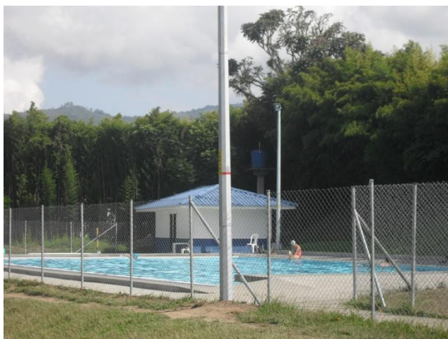
Foto No.30: Piscina semi-olímpica Fuente: Propia.
