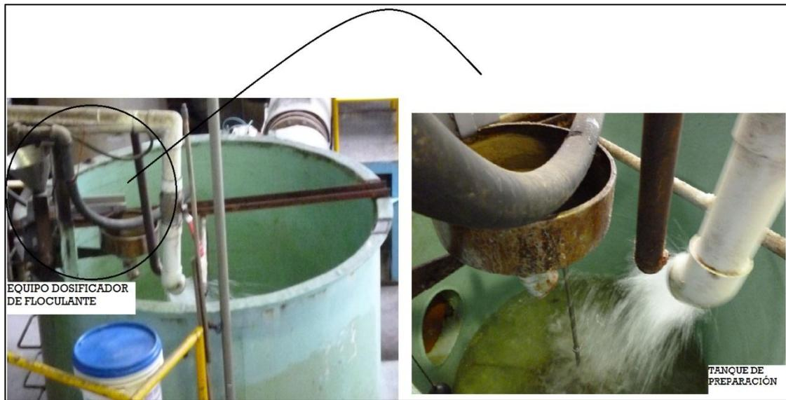
**Figura 33. Equipo dispersor de floculante y flujo de agua de preparación.**
