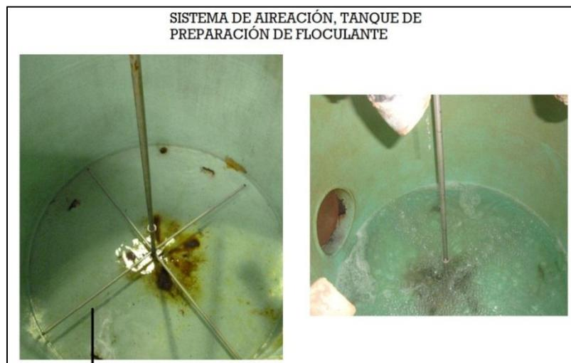
**Figura 34. Sistema de aireación de la solución floculante.**
