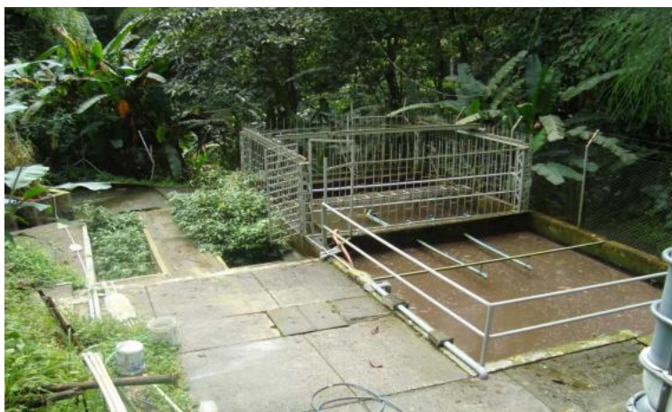
Figura No. 1 PTAR-UTP Sistema de Lodos Activados Fuente: Caro (2009)
