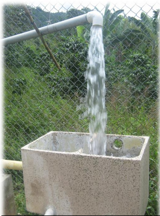
Sistema de filtración del agua A.A.C. Nueva Colombia
