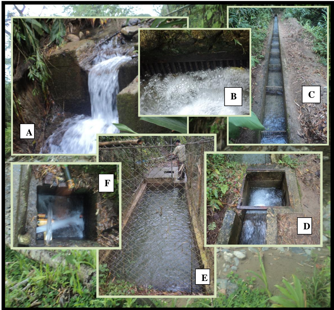
Foto 9: Componentes infraestructura de captación del recurso hídrico del sistema de acueducto comunitario de la A.A.C. la Mariana. En su orden se presentan: Quebrada Roca Verde -fuente abastecedora de agua (A), bocatoma lateral (B), canaleta parcha (C), canaleta de filtro (D), tanque de filtro y desarenadores (E) y tubos de entrega sobrante de agua. Fuente: propia (2011).
