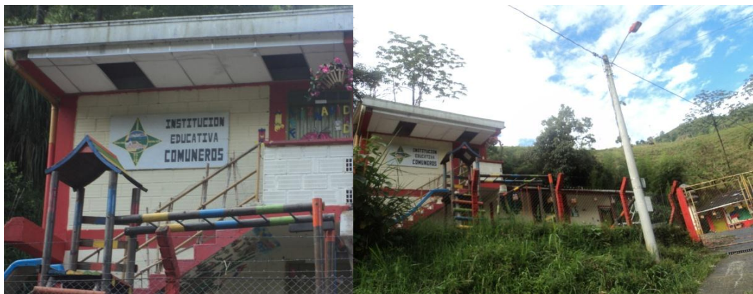
Foto 2: Mosaico fotográfico de las Instalaciones Centro Educativo los Comuneros. Fuente: Propia (2011).
