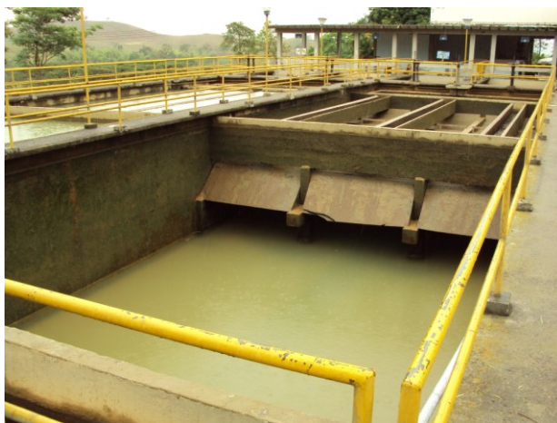
Fotografía 3. PTAP La Virginia
