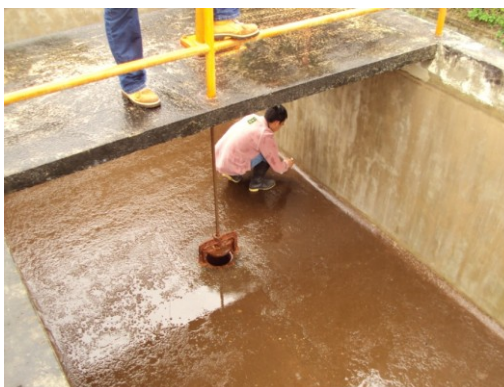
Fotografía 9. Sedimentador PTAP La Celia
