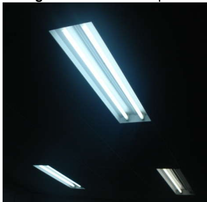
Figura 8. Sala de cómputo.
