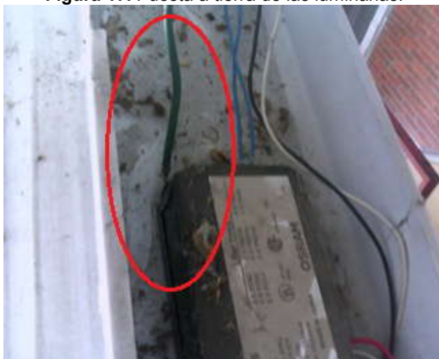
Figura 17. Puesta a tierra de las luminarias.
