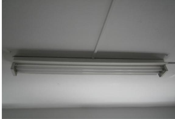
Luminaria para lámpara tipo T8 de 5 000 lm. Se encuentra en la mayoría de las áreas inspeccionadas del bloque de Ingeniería Eléctrica.
