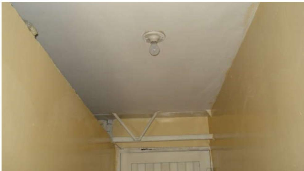
El uso de bombillas incandescentes en la instalación eléctrica de la planta de alimentos FUNDASUPERIOR es recomendable cambiarlas por bombillas compactas (ahorradoras) que tienen una alta eficiencia.
