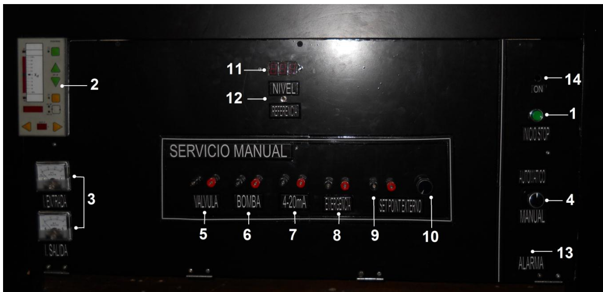
Figura 100. Panel de control del sistema
