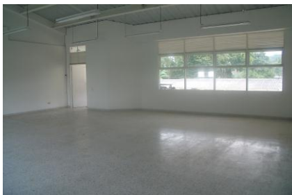
Figura 37: salón para la sala de sistemas del bloque 3 piso 2
