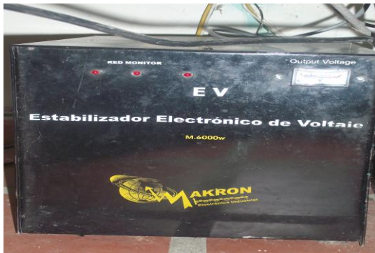
Figura 23: Estabilizador de tensión
