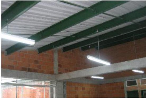
b) Se comprobó que las cubiertas metálicas existentes no presentan ningún signo de oxidación. Según el fabricante están construidas en lámina de acero estirada en frío y tratadas contra la corrosión mediante baño químico de fosfatado por inmersión en caliente.
