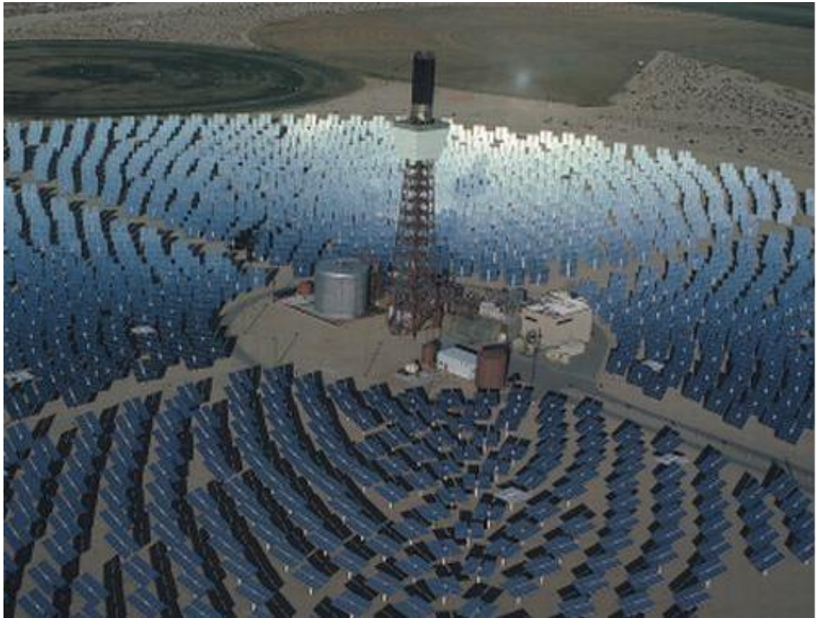
Figura 22. Central de Generación Termo Solar de Torre
