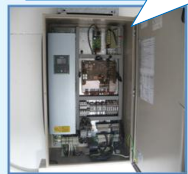
Figura 620-18. Sistema de control de un ascensor.
