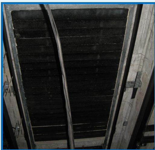
Figura 620-7. Ejemplo de contrapeso utilizado en ascensores hidráulicos.
