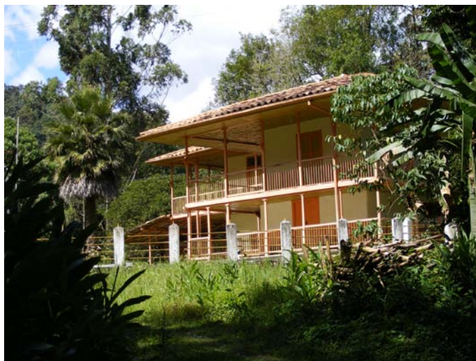
Foto 3. Casa Villa Amparo. Vereda La Suiza.
