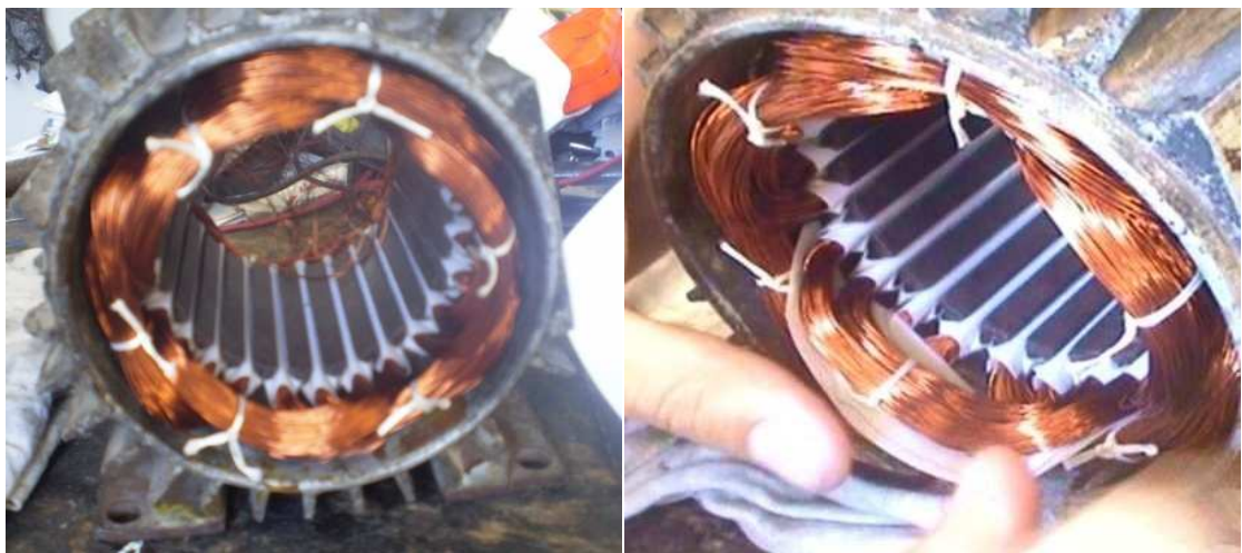
Figura 2.22. Amarrado de las cabezas de las bobinas y asilamiento entre grupos de bobina.
