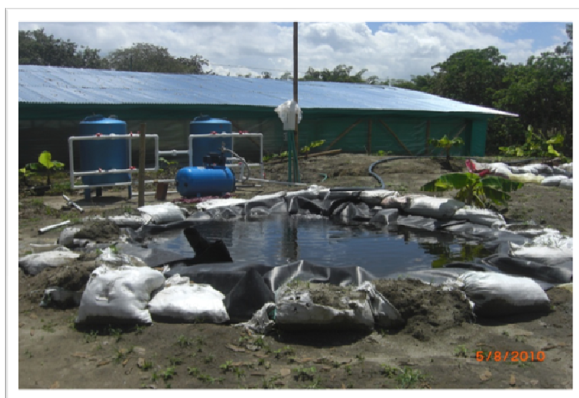
Foto 8. Bombeo para captación de corrientes de agua.
