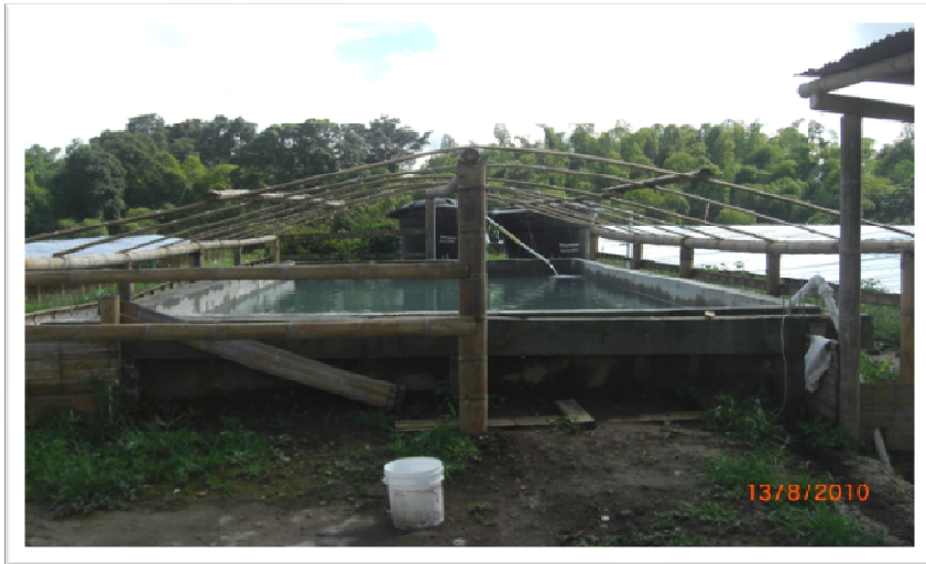
Foto 4. Tanque de Reserva
