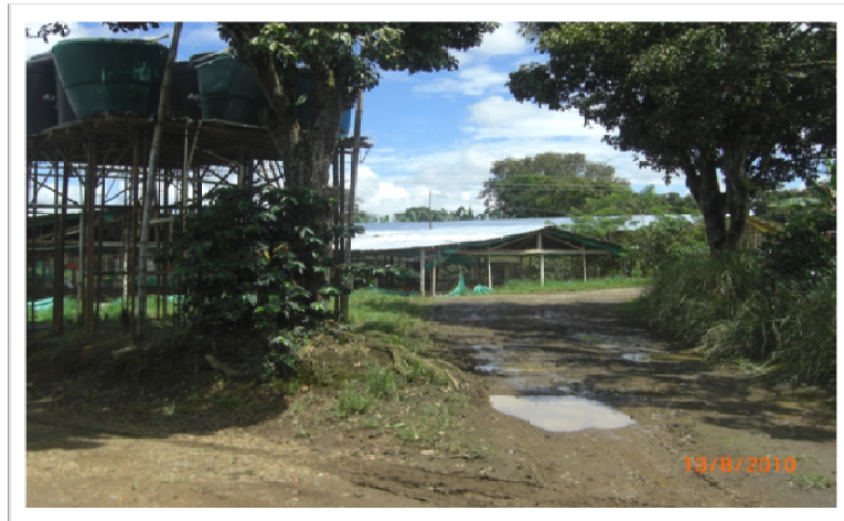
Foto 3. Tanques para Abastecimiento de Galpones.
