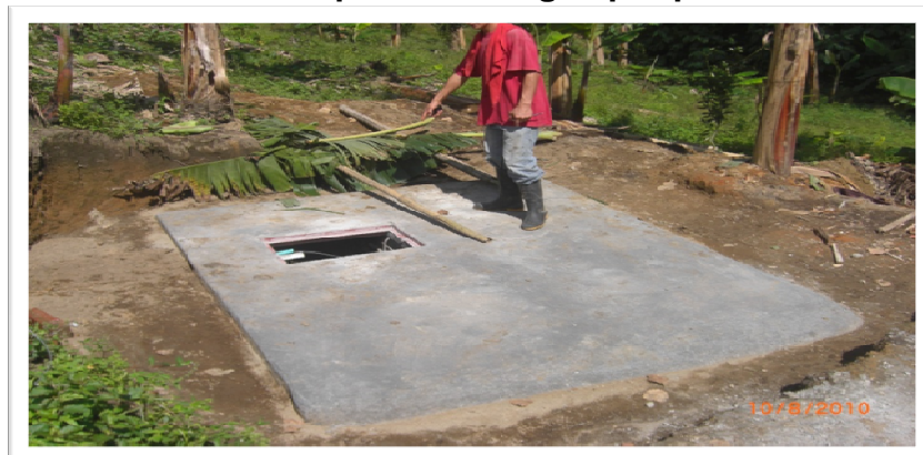
Foto 7. Captación de agua por pozos
