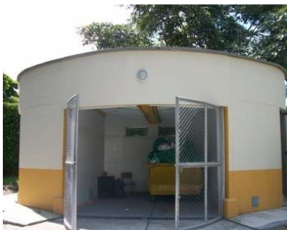
Fotografía 17. Cuarto de residuos no peligrosos.
