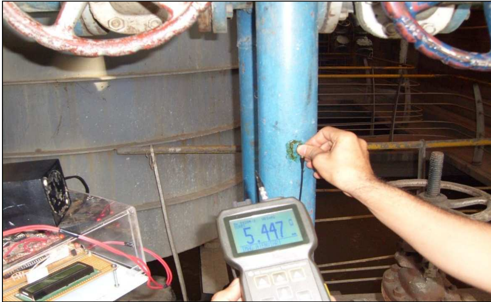
Figura Planta de agua Tubo N°3 Acero (equipo IRIS A)
