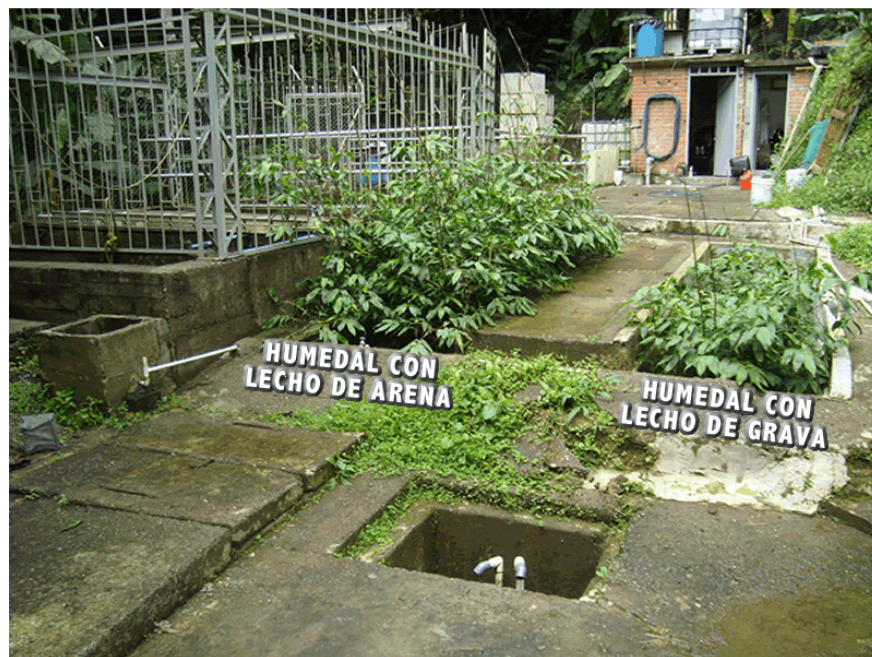
Figura 14: Humedales artificiales con 41 semanas de funcionamiento. Fuente: Autores
