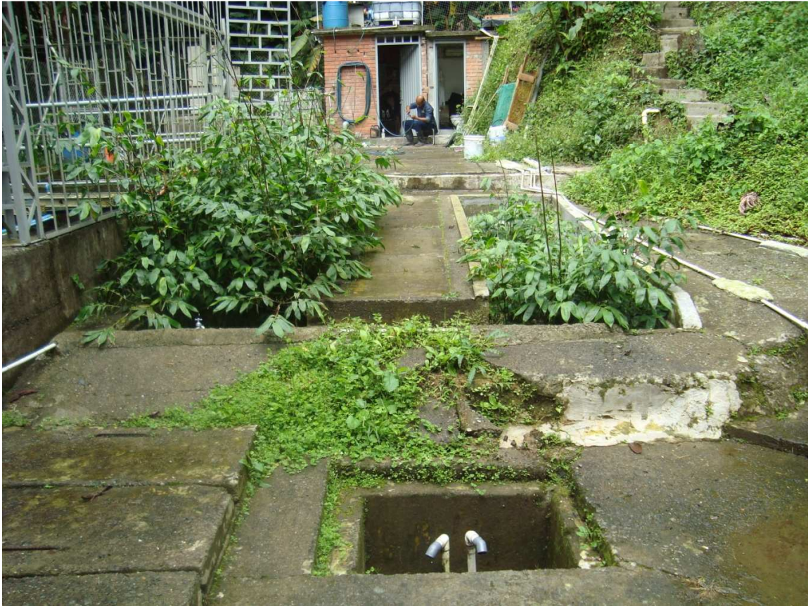
Unidades experimentales, Humedales artificiales de flujo subsuperficial horizontal. Planta de tratamiento de aguas residuales. Universidad Tecnológica de Pereira.
