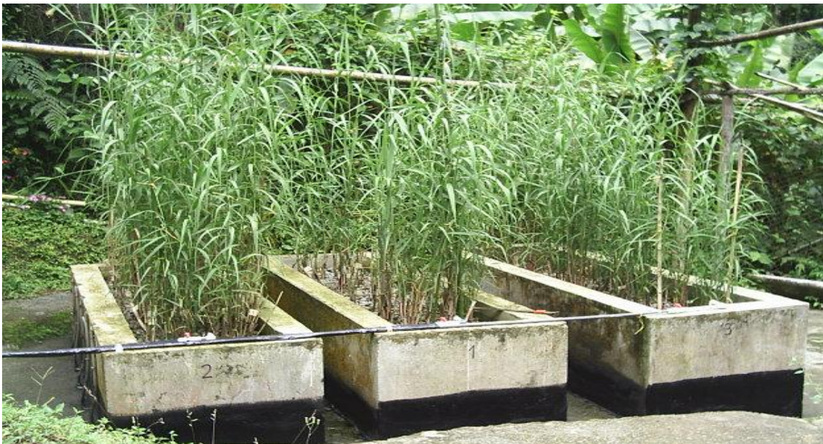
Foto 4: Humedales artificiales Enero de 2008
