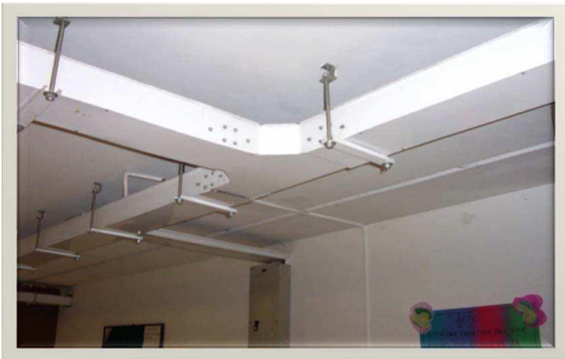
Figura 6 Distribución del cableado en bandeja y canaleta
