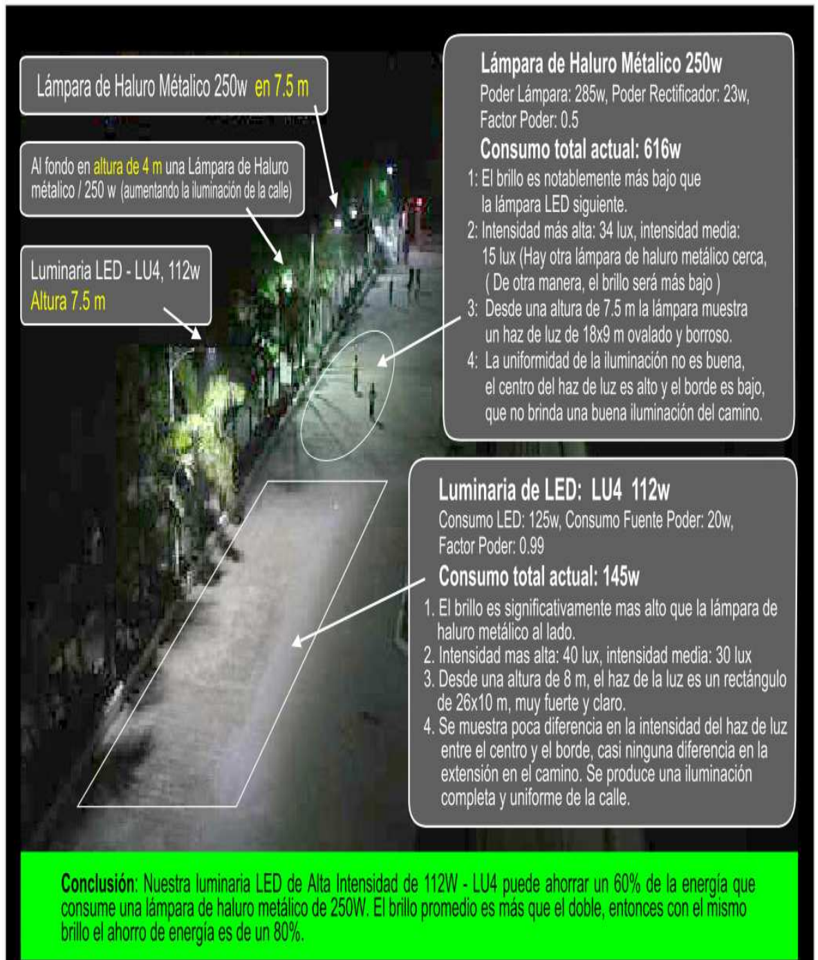
Figura 45. Comparación entre una lámpara de haluro metálico 250W y una luminaria de LED's de 112W
