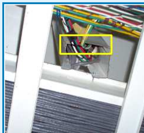
Figura 318-2. Elementos cortantes en las bandejas
