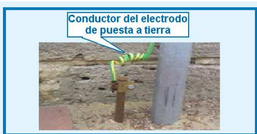
Figura 250-32. Conductor del electrodo de puesta a tierra.
