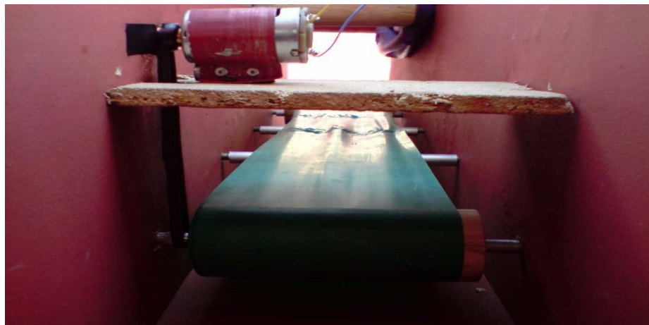
Figura 16. Imagen de la banda transportadora del subsistema de almacenamiento.
