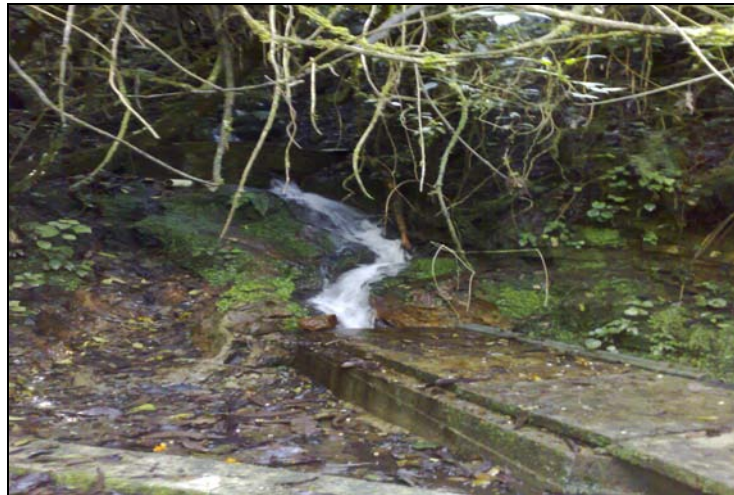
Figura 20. Captación acueducto Villa Nueva Alto
