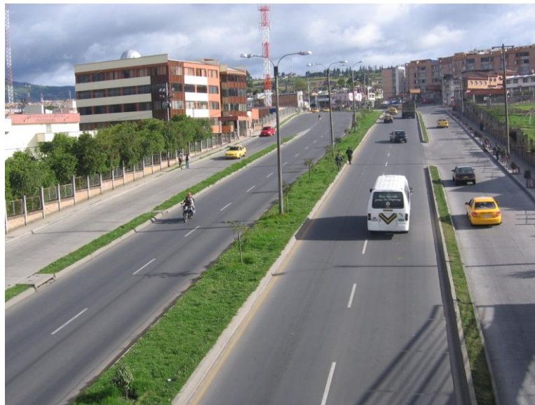
Figura No.12. Pavimentación Avenida Panamericana
