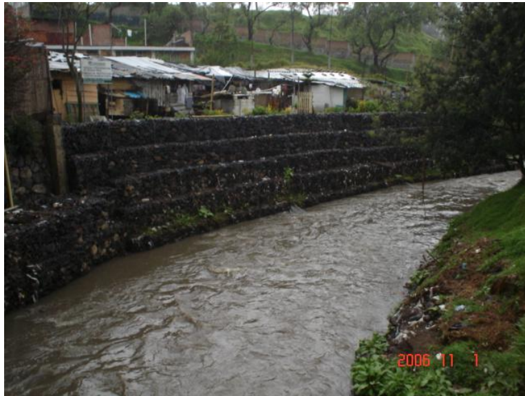
Figura N° 5. Estructuras elaboradas sobre el Río Pasto
