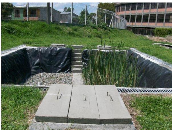
Figura 30. Planta de tratamiento de aguas residuales (humedal Artificial)
