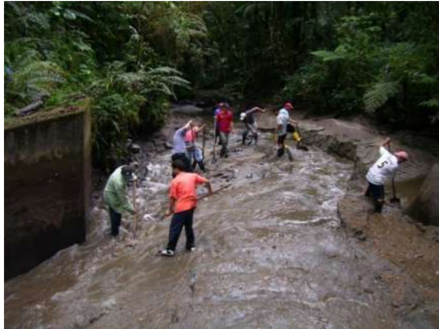
Acompañamiento a los operarios de la ESPTRI para el mantenimiento de la bocatoma en el rio Barbas
