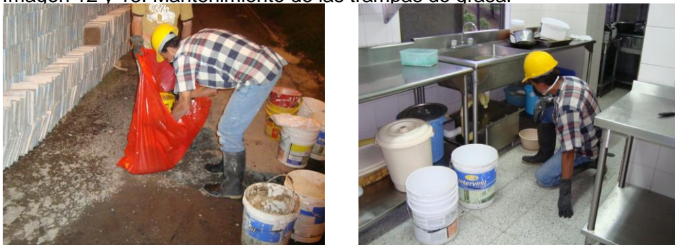
Imagen 12 y 13. Mantenimiento de las trampas de grasa.
