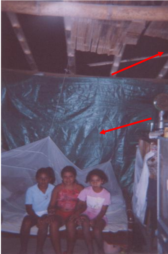
Foto 12. Tomada al interior de las viviendas. Nótese material de techo y paredes.
