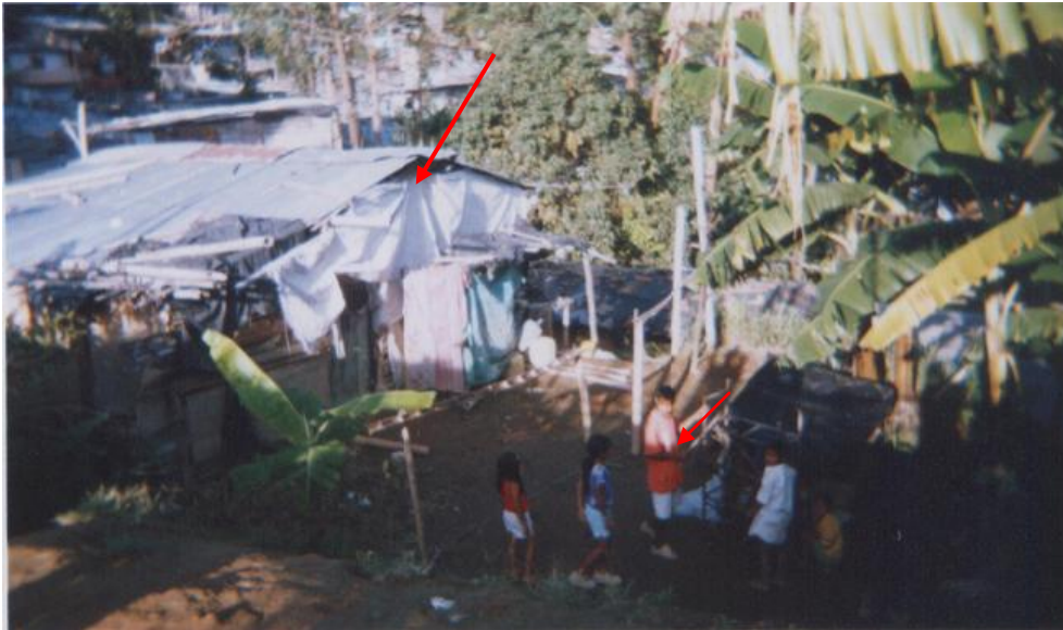
Foto 14. Panorámica del estado actual de las viviendas. Nótese vías de acceso y materiales.
