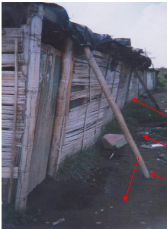
Foto 19. Viviendas del sector que están siendo deterioradas por factores ambientales naturales y debido al tipo de construcción.
