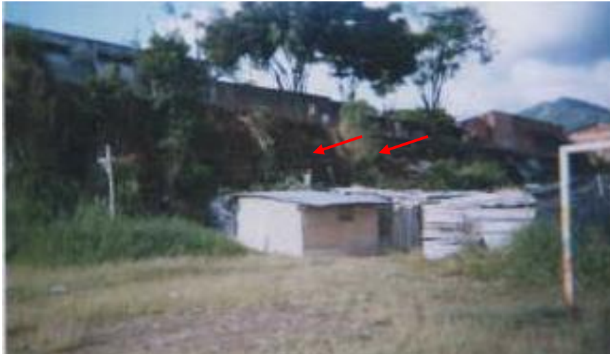
Foto 3. Trinchos ubicados en alud de tierra. Zona de Colegio Aquilino Bedoya.
