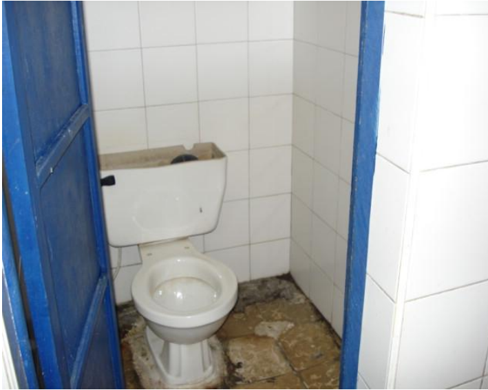
FOTO 4: Se aprecia el tipo de sanitarios instalados
