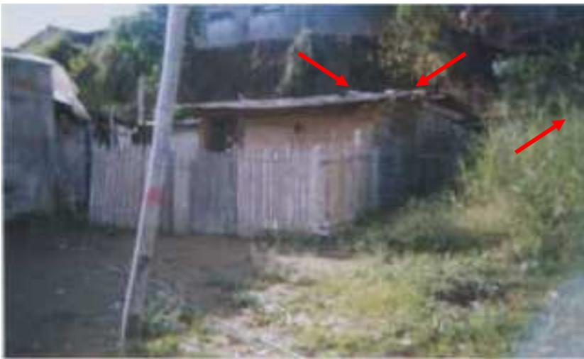
**Taludes verticales antrópicos.** Hacen parte las zonas intervenidas por los habitantes del barrio con el fin de efectuar ampliaciones de sus viviendas hacia la parte superior, lo que genera la conformación de una superficie subvertical a vertical la cual es continuamente intervenida mediante excavaciones y retiro de materiales. Se localizan en especial sobre la parte posterior de las viviendas que se asientan sobre las vías principales de acceso al barrio.
