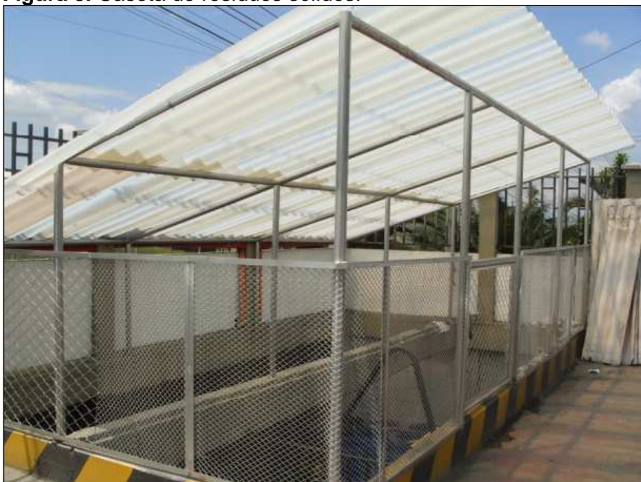
Figura 3. Caseta de residuos sólidos.
