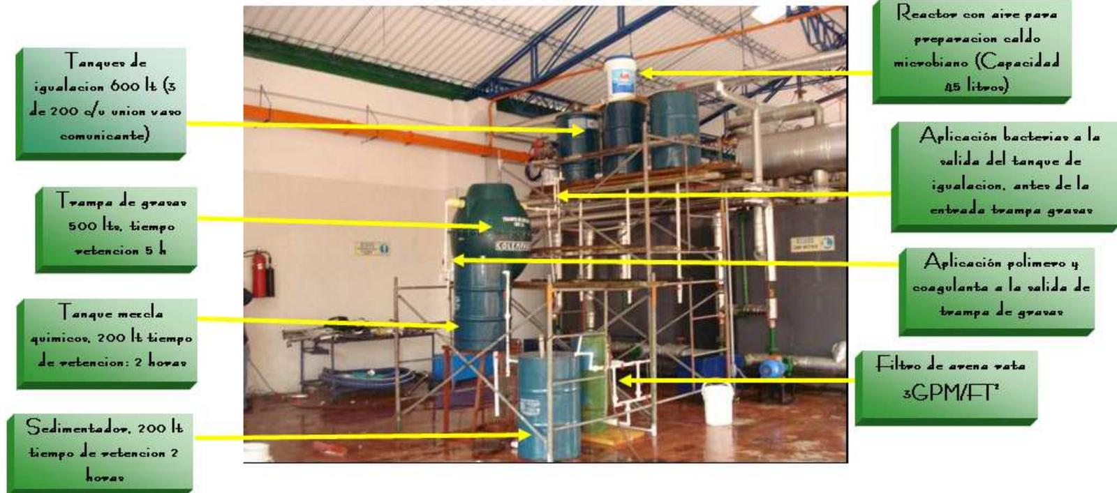
La PTAR posee en su orden: rejilla de desbaste con su respectivo riel, caja de igualación, trampa de grasas, tanque para mezcla de insumos químicos, sedimentador 1, sedimentador 2, filtro de arena, espesador de lodos, tanque de 250 litros para preparación de químicos y bombas dosificadoras de insumos químicos. Se realizó una descripción específica de cada etapa del sistema de tratamiento de aguas residuales industriales ALIVAL S.A:
