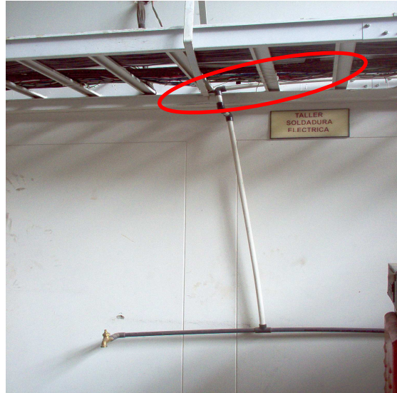
Figura 32. Transporte de conductores eléctricos
