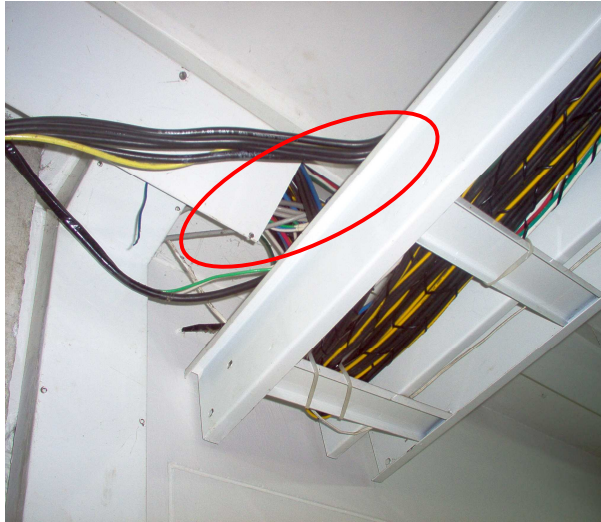
Figura 30. Canalización con salientes (segundo piso)
