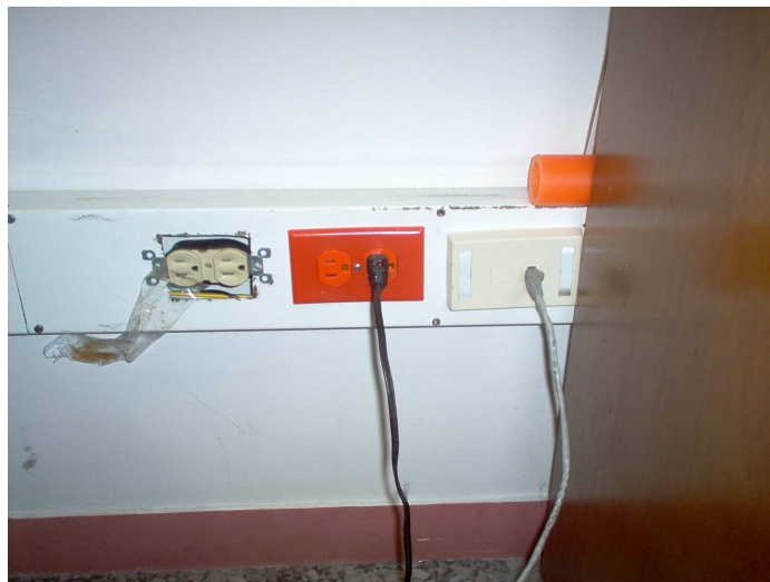
Figura 49. Cubículo 12 (segundo piso)
