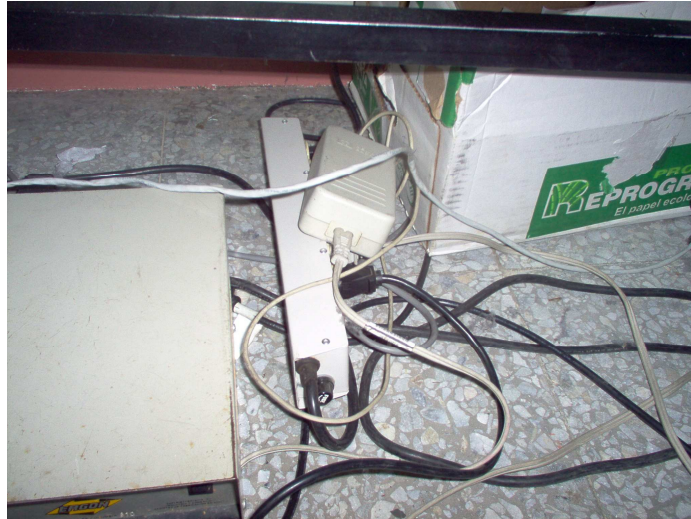
Figura 48. Cubículo 14 (segundo piso)
