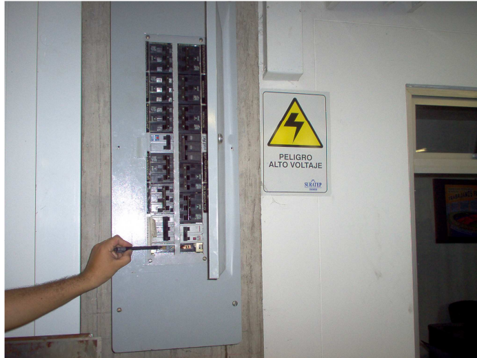
Figura 21. Aberturas sin tapar tablero taller 2
