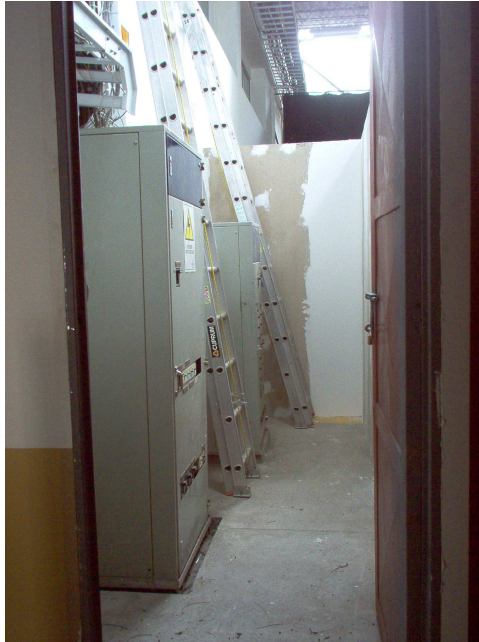
Figura 10. Cambios en la subestación (octubre 2007)
