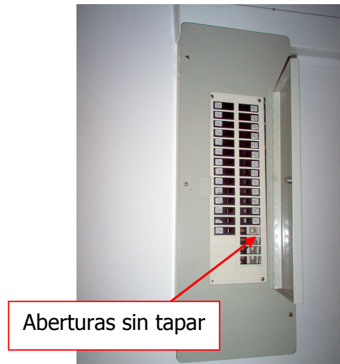
Figura 25. Tablero corredor segundo piso
