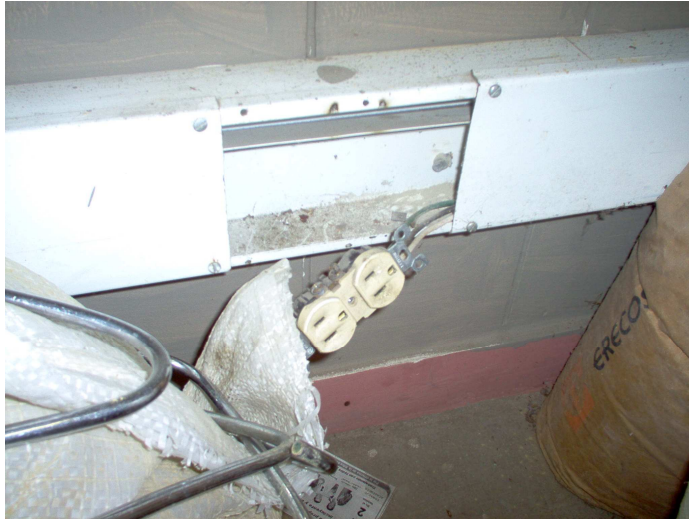
Figura 47. Cubículo 22 (segundo piso)
